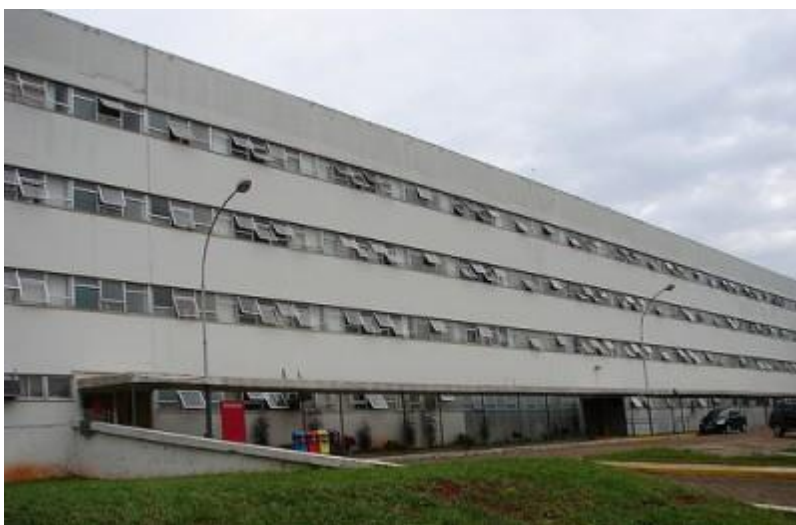
Figura 1: Fachada principal do prédio Alojamento
